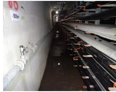
통신구 배수로 채수 (STA. 780m~1,160m)
