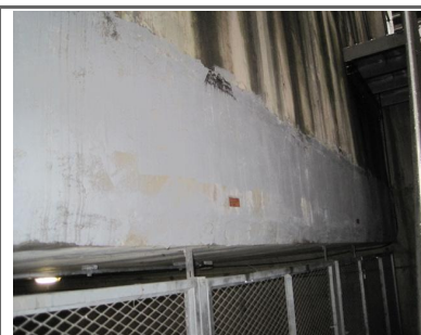
#7 수평구 벽체 백태 보수
