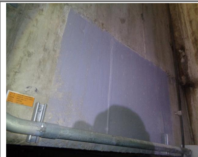
#28 수직구 백태 보수완료
