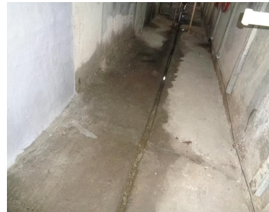
상수구 배수로 채수 (STA. 1,660m~1,700m)
