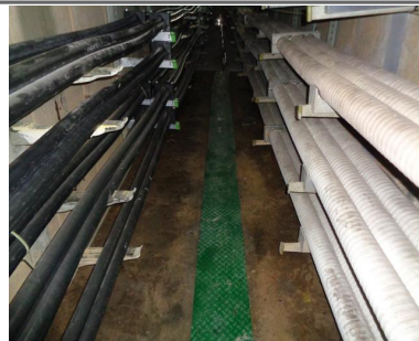
전력구 배수로 채수 (STA. 920m~1,040m)
