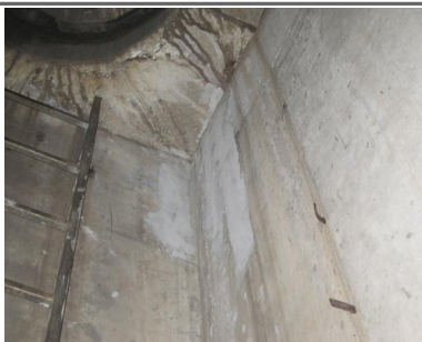
#38 맨홀 철근노출 보수
