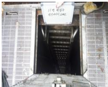
#11 작업구 수직사다리 현황
