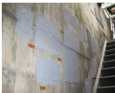
#29 수직구 철근노출 보수완료
