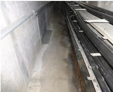
통신구 배수로 채수 (STA. 780m~1,160m)
