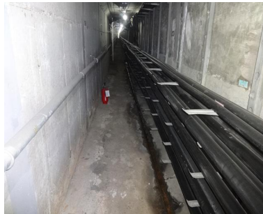
통신구 배수로 채수 (STA. 1,440m~1,480m)
