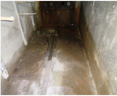
통신구 배수로 채수 (STA. 0m~80m)
