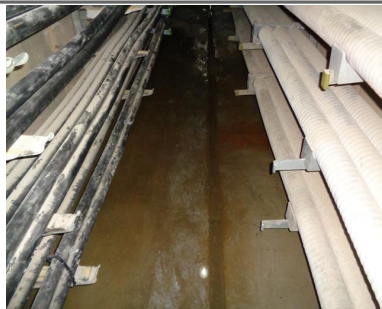
전력구 배수로 채수 (STA. 920m~1,040m)
